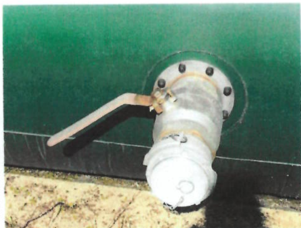
2 vannes de sortie existantes
